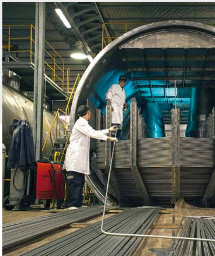
НАБИВКА ПАРОГЕНЕРАТОРА ДЛЯ АЭС «КУДАНКУЛАМ»
