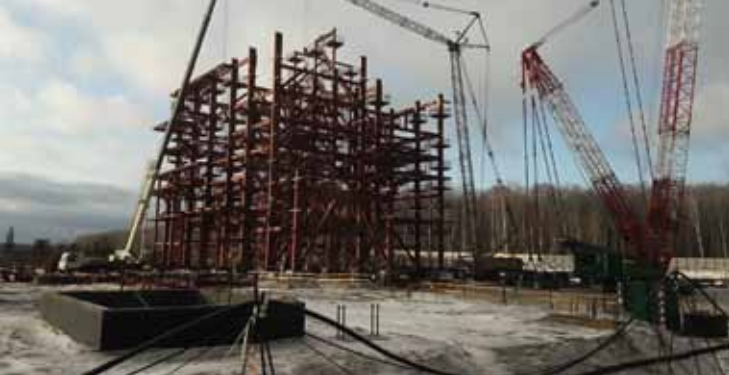
МОНТАЖ ПАРОВОГО КОТЛА В П. СВИСТЯГИНО
